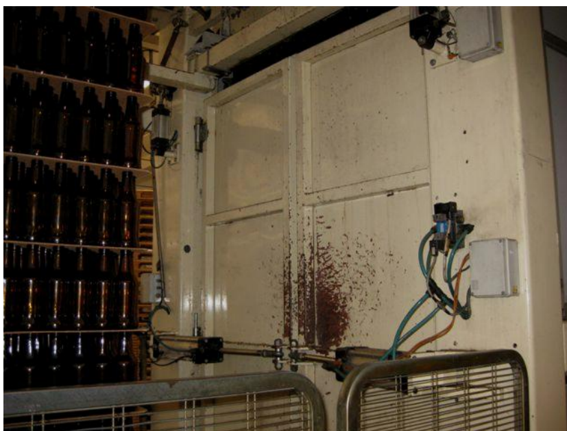
Figura 3 - Entrada do Elevador de Bulks
